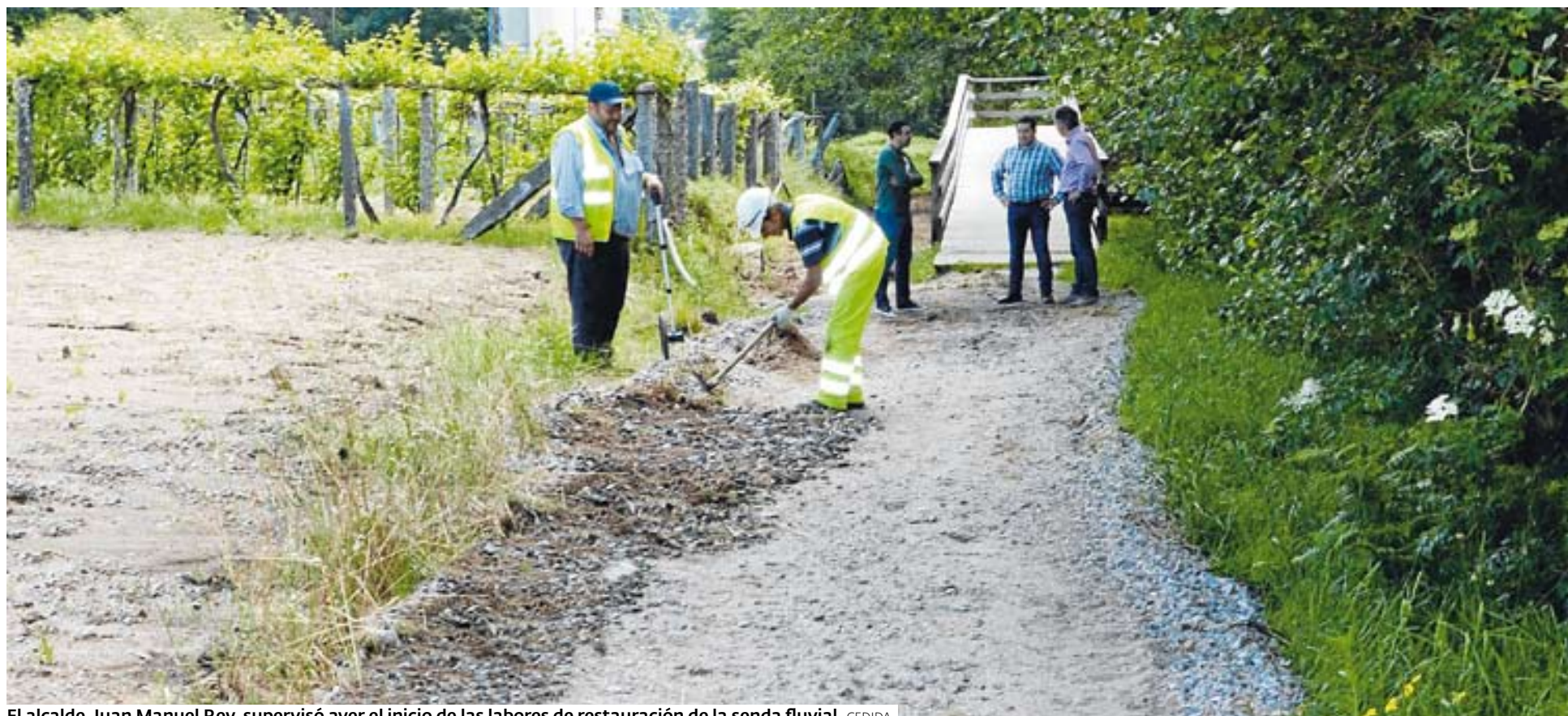
El alcalde, Juan Manuel Rey, supervisó ayer el inicio de las labores de restauración de la senda fluvial. CEDIDA
