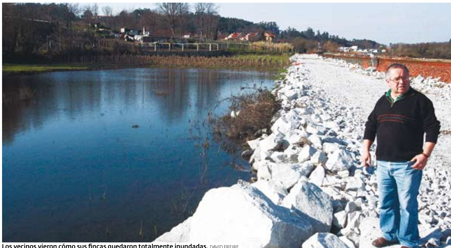
Los vecinos vieron cómo sus fincas quedaron totalmente inundadas. DAVID FREIRE
